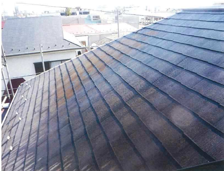
屋根塗装工事
