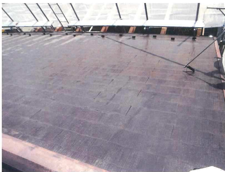
屋根塗装工事
