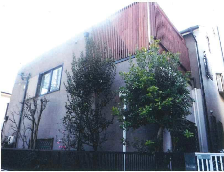
足場工事(北、西面)
