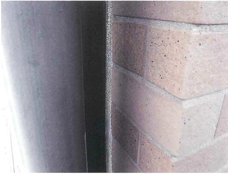
NO.2東面サッシ廻り
