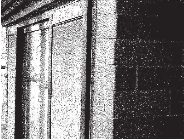
NO. 3東面サッシ廻り
